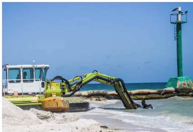
Figura 41. Dragado de playa en la entrada del puerto de abrigo de Telchac puerto Yucatán.
