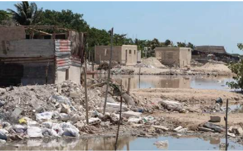
Figura 42. Destrucción de manglares en la zona de Progreso y Chicxulub Yucatán para la construcción de viviendas irregulares.
